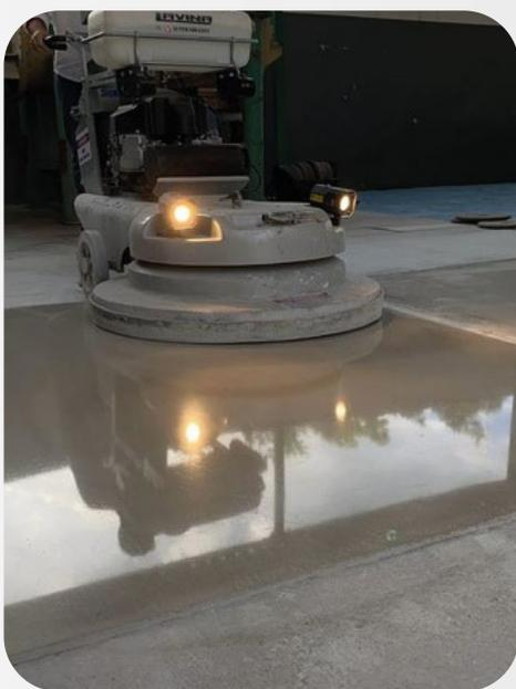
*A revitalização do uretano consiste em processos de leve nivelamento da superfície, para retirar marcas do rolo ou qualquer imperfeição que tenha ficado durante a aplicação, e o fechamento de porosidade com discos diamantados, que proporciona um excelente brilho.*
